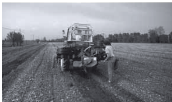
Fig. 25 Un detalle de la operación de la colocación mecanizada de la tubería de subirrigación. Foto P. Gasparinetti
