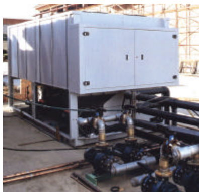
Equipos de producción de frío en una bodega
