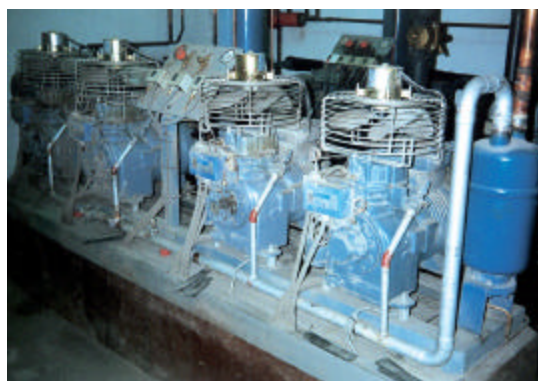
Equipos de producción de frío en una bodega
